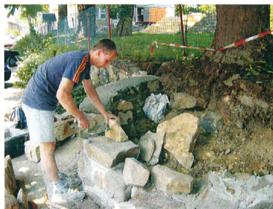
Um den alten Baum zu erhalten, wird die Außenmauer als Rondell versetzt: Zivi Daniel Krüger bei der Arbeit
