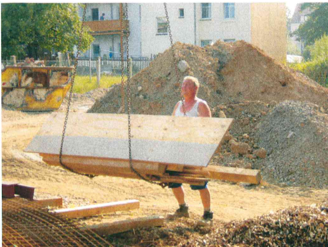
Mit dem großen Drehkran wurden die neuen Balken ins Dachgeschoß gebracht
