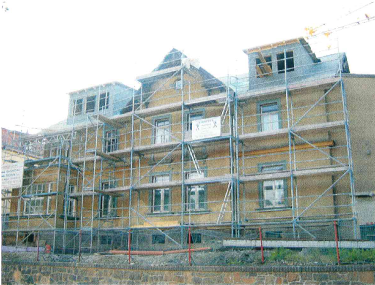
Das Gerüst der Fa. Döwa steht
