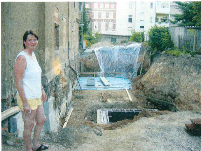
C.B. schlug im Scherz schon eine Umfunktionierung der Aushubgrube zum Schwimmbad vor
