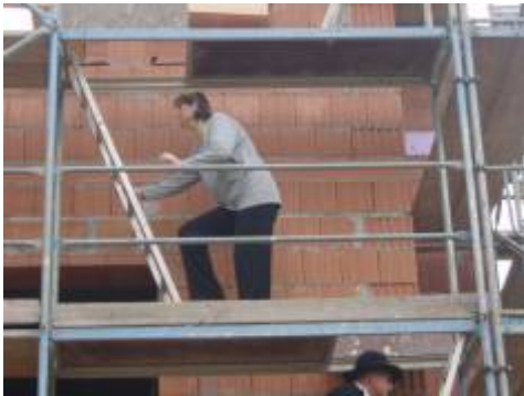
Aufstieg zur Richtfestkrone, ob die Leiter auch richtig feststeht?
