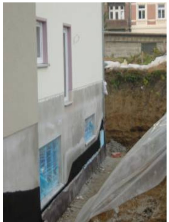
Nordseite Neubau - Schulungsraum
