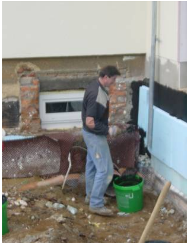
Anbringen der Wärmedämmung an den Neubau (Hr. Noatsch)
