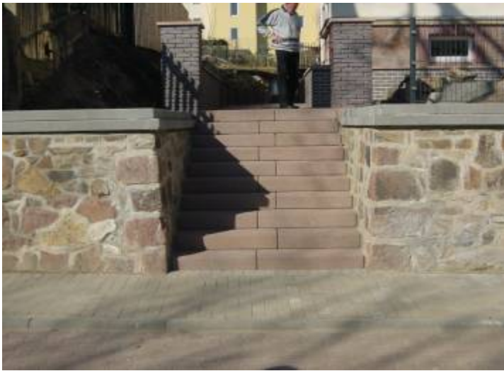
der Nebeneingang zur Häuslichen Krankenpflege - ehemaliger Weg für Kinderwagen
