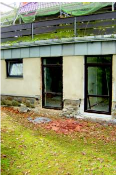
ebenerdig eingebaute Türen
