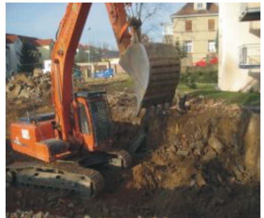
Abrissbagger im März 2008
