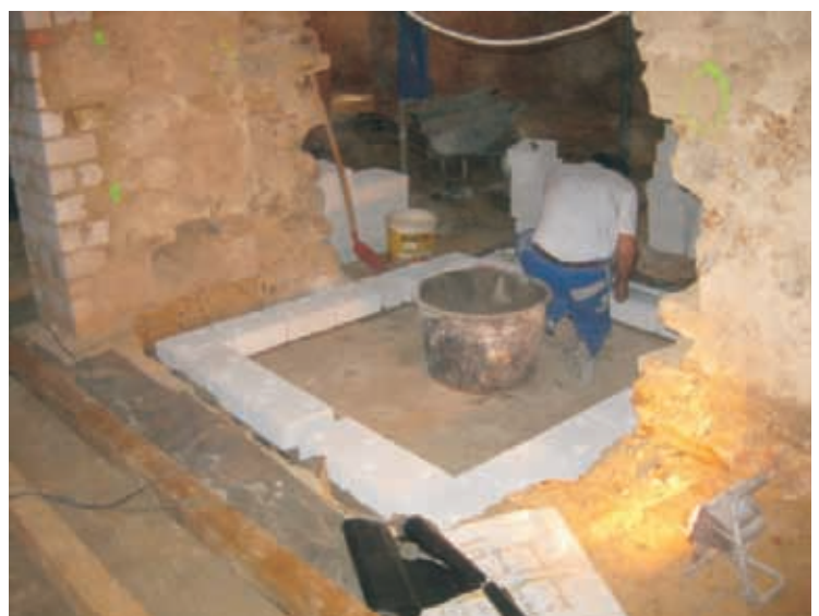
Entstehung des Fahrstuhlschachts
