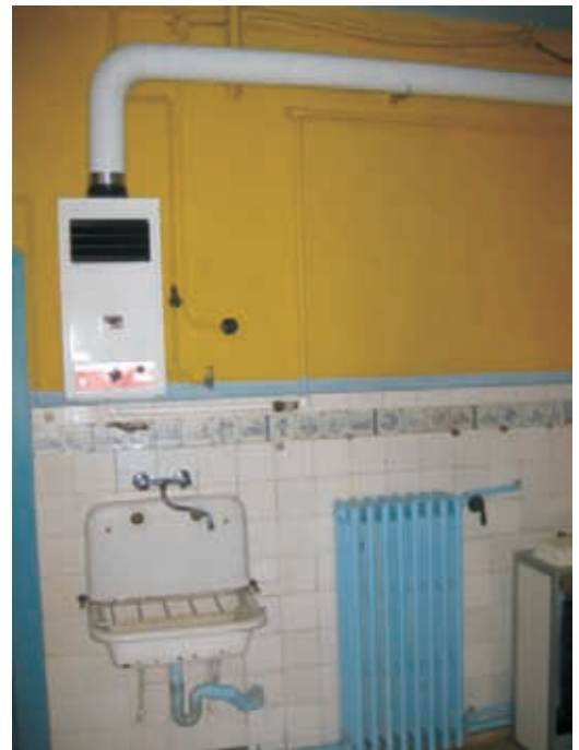
Ansicht eines Bades vor dem Umbau
