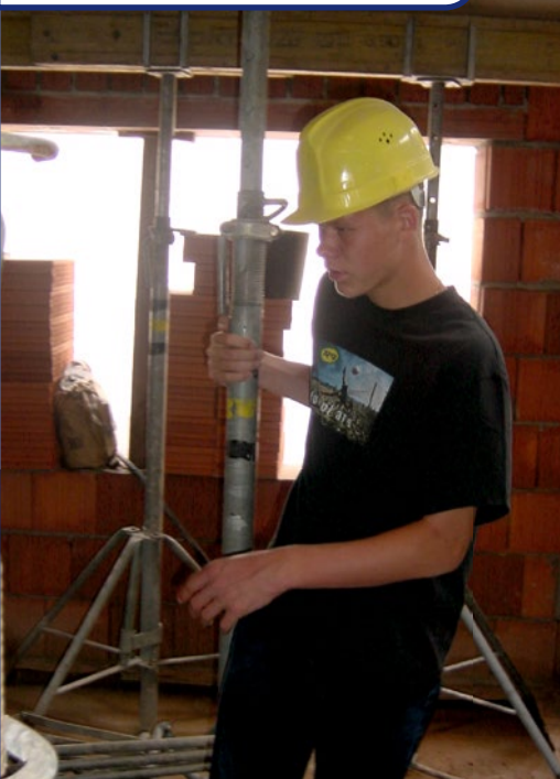
Benjamin Brambor auf der Baustelle der späteren Villa „Zum Rüderpark“
