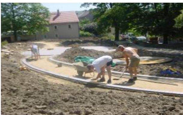
die Grünanlage entsteht - rasche Fortschritte sind jeden Tag zu sehen
