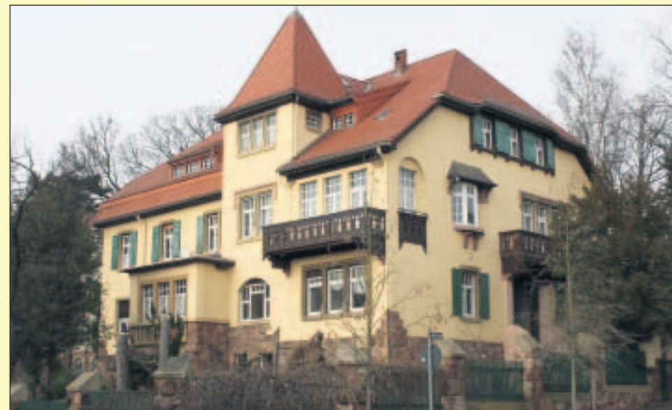
Das ist die Villa Brambor in der Bertholdstraße 1 in Döbeln.
